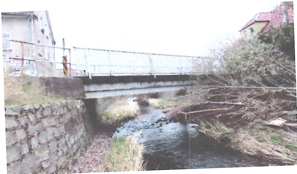
Fot. 3. Elewacja obiektu
