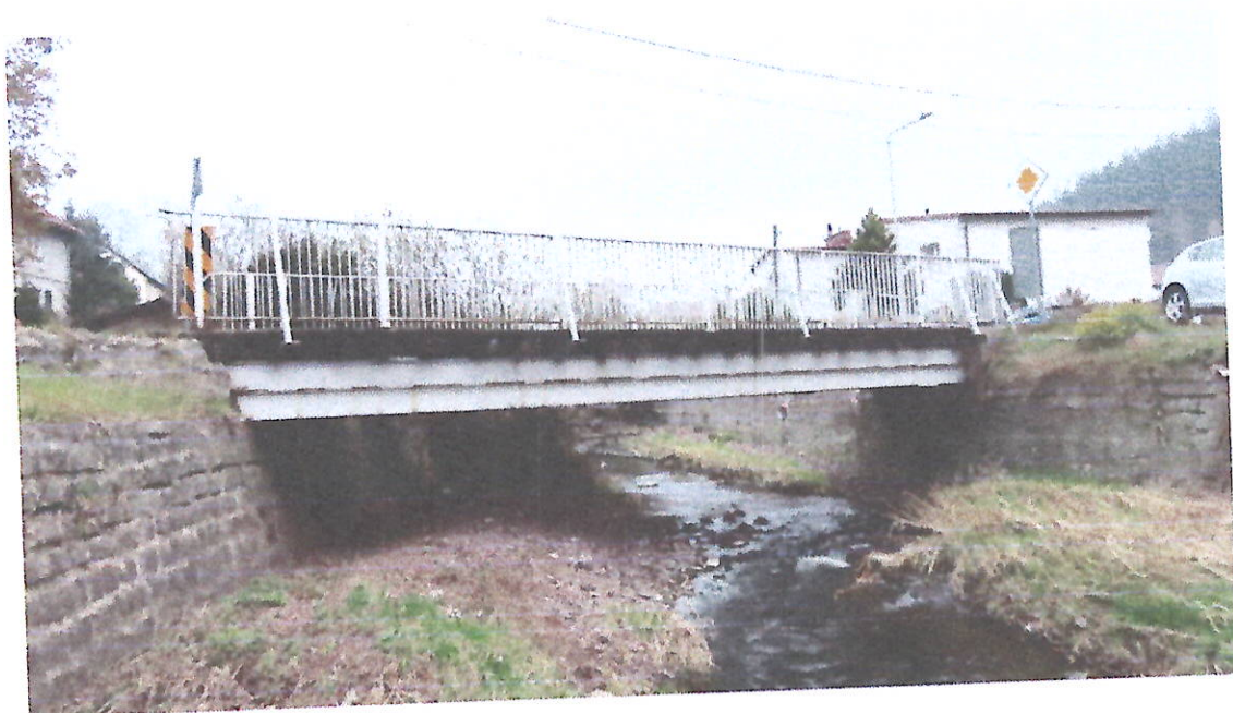
Fot. 4. Elewacja obiektu
