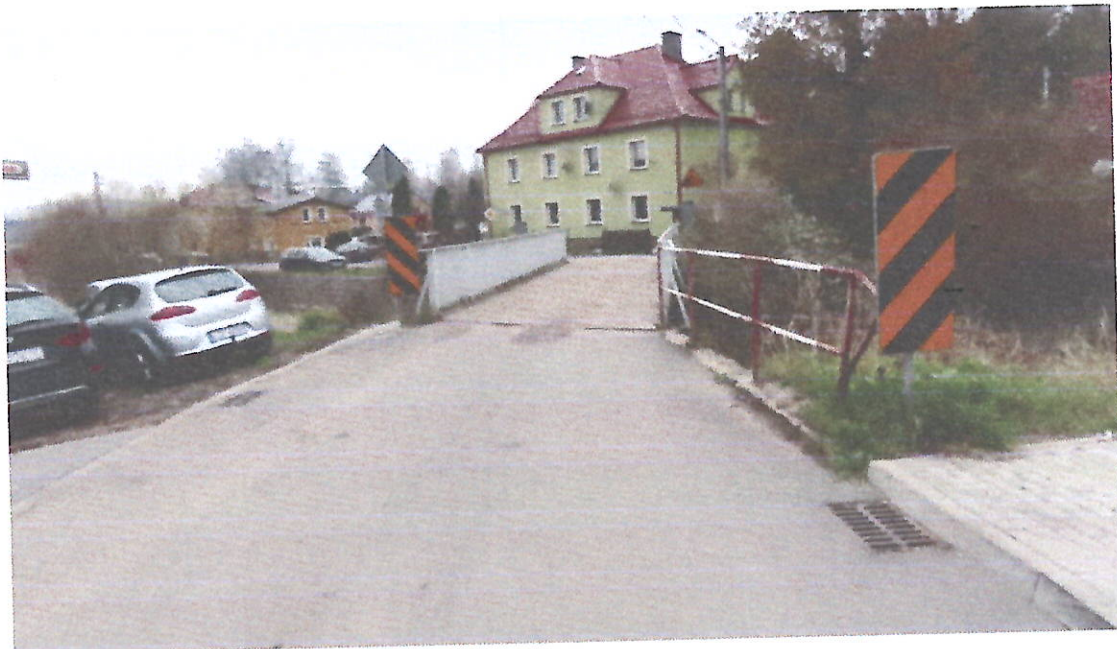
Fot. 1. Widok na obiekt
